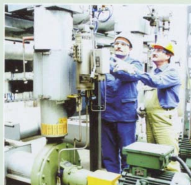
Betriebstechnikteam bei Kontrollarbeiten
